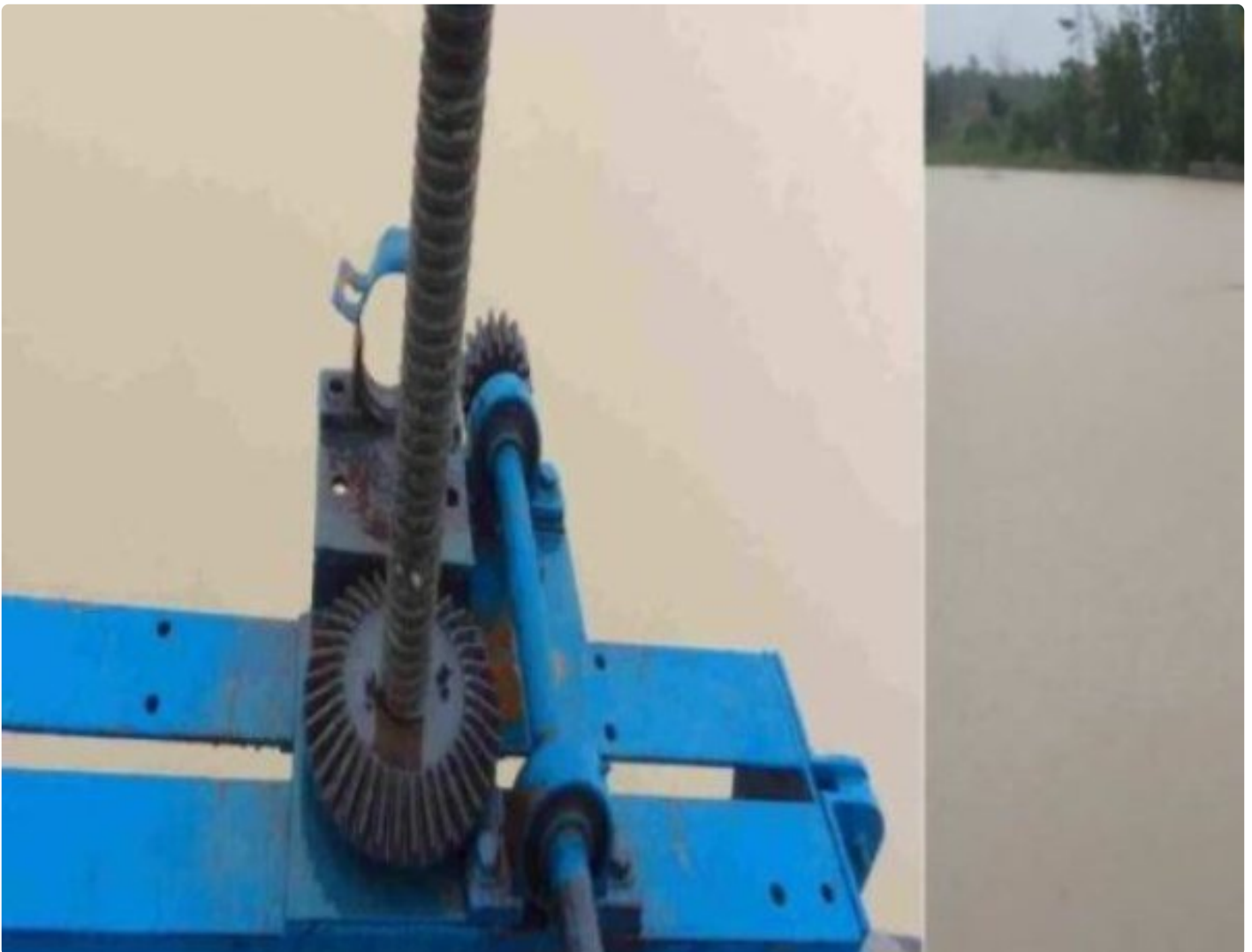
Pintu air Albaret Simpang Mesuji
